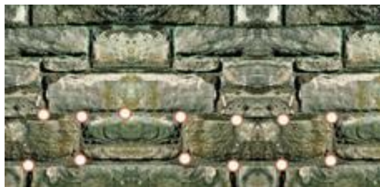
Схема расположения отверстий в каменной кладке.
