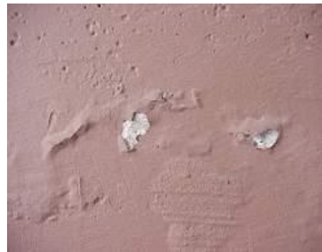
Вспучивание покрытия
